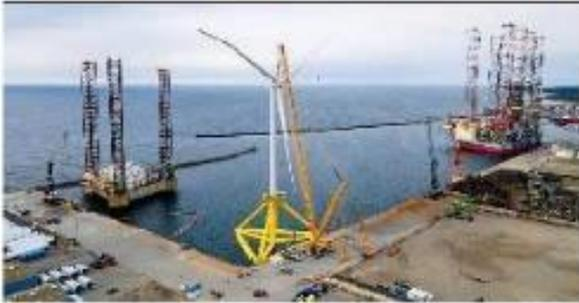
Le turbine e la sottostazione elettrica FOS sono installate sulle relative fondazioni mediante gru. La geometria del Tetrasub consente l'agevole accosto della fondazione alla banchina riducendo le sollecitazioni sulle gru.
