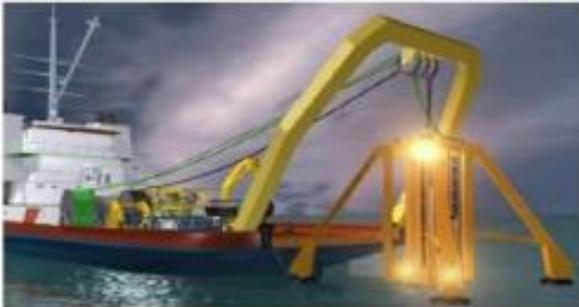
La prima fase di posa dei sistemi di ormeggio e dei relativi sistemi di ancoraggio al fondale marino è sostanzialmente identica per i sistemi turbina galleggiante e FOS eccetto per l'eventuale differente dimensione dei componenti. Ai fini della presente analisi si considera la condizione di calcolo più gravosa ipotizzando l'installazione di sistemi di ancoraggio a pali infissi.
