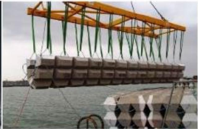
**Figura 17:** Fasi di costruzione cavidotto marino
