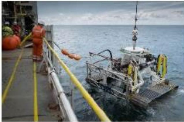
La posa dei cavi della rete inter-array viene effettuata, per ogni coppia di FOU, mediante apposita imbarcazione posa cavo (MPSV/AHTS) che procede alla stesura muovendosi da un generatore al successivo o verso la FOS. Previo collegamento elettrico su ciascuna FOU, con apposito mezzo di supporto, si procede quindi, in relazione alla strategia di protezione del cavo, all'eventuale applicazione di rocce/materassini o, mediante *trencher*, allo scavo, interrimento e ricopertura del cavo.
