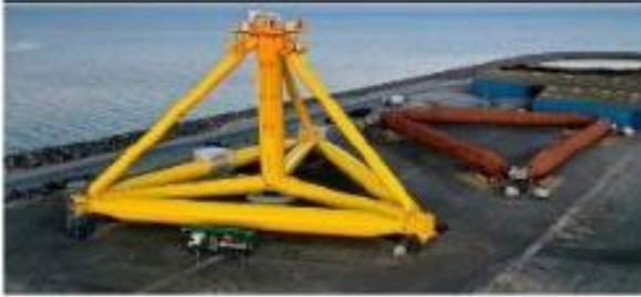
L'assemblaggio delle strutture di fondazione galleggianti è effettuato in area portuale presso banchina idoneamente strumentata.
