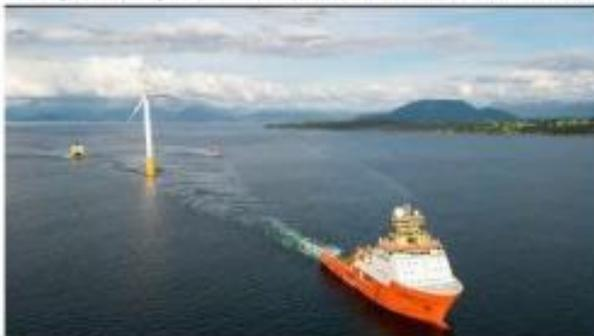
La struttura di fondazione e la sovrastruttura (turbina o sottostazione elettrica FOS) sono assemblate direttamente in area portuale e trainate in regime di galleggiamento mediante un sistema di rimorchiatori. Una volta in posizione si procede al collegamento con le linee di ormeggio pre-posate, eventuale zavorramento fino al pescaggio desiderato e tensionamento delle linee di ormeggio.
